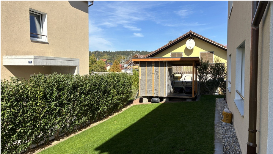
Genehmigtes Gartenhaus aktuell im Bau
